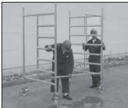
Figur 10 Horisontalstiver monteres
