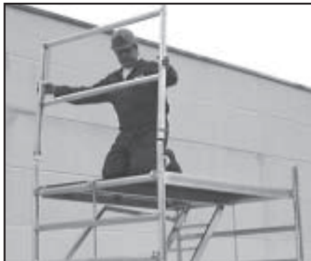
Figur 24 Gelænderramme anbringes
