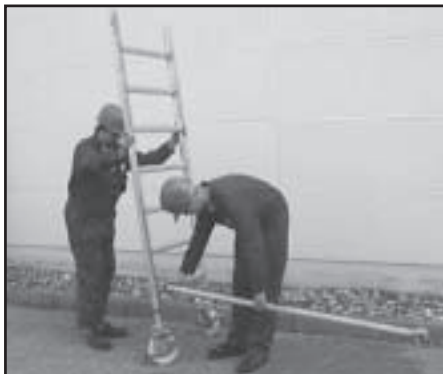
Figur 15 Horisontalstiver monteres
