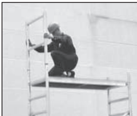
Figur 27 Gelænderrammer anbringes
