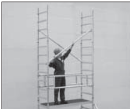
Figur 25 Diagonalstiver sættes på
