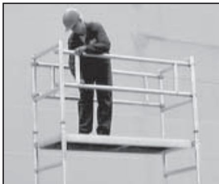
Figur 26 Gelænder anbringes
